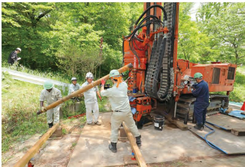
リニューウェル工法によるケーシング抜管状況
